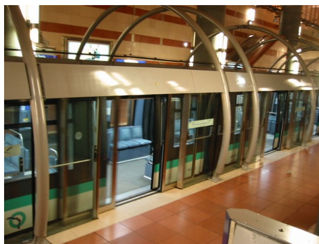
パリのドライバレス地下鉄 (a) Driverless subway line in Paris
